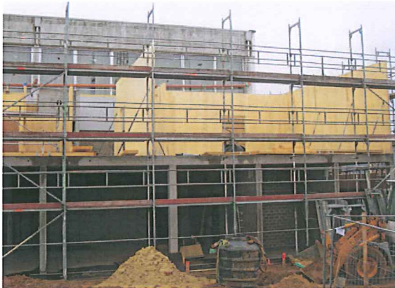
Bau der Maison Relais in Künzig
