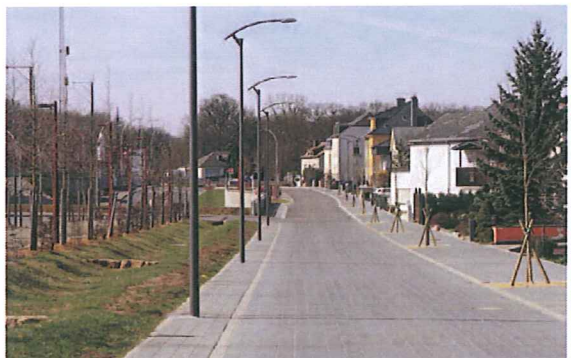
Rue Continentale im neuen Gewand
